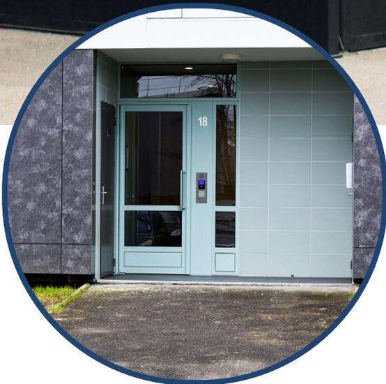
Les vantaux possèdent des dimensions variables dans les limites de L 1100 x H 3000 en un vantail et de 2 x 1100 x 3000 en deux vantaux, des châssis fixes latéraux dans les limites de L 1500 x H 3000. La finition du SMHall est thermolaquée en usine.
